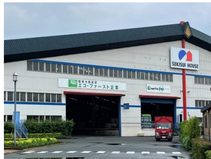
工場の壁面 (積水ハウス株式会社)
