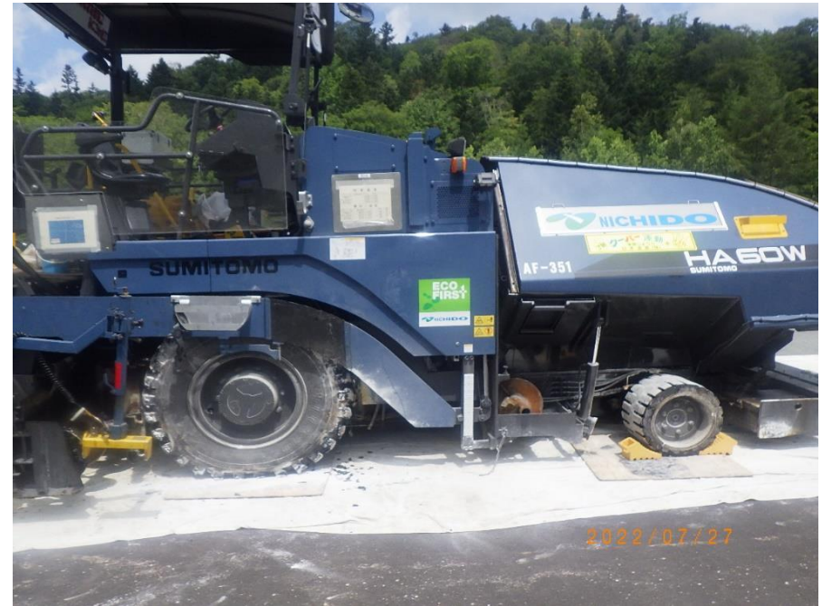
重機 (日本道路株式会社)
