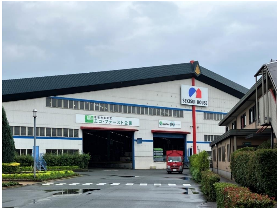
工場の壁面 (積水ハウス株式会社)
