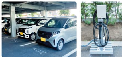
EV車両・普通充電器 導入設置例
