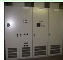
キャパシタ（風力発電などに併設して出力変動の準化を行うもの。）
