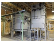
<Li-ion電池リサイクル設備>
