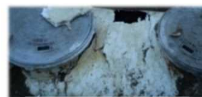
老朽化している単独 処理浄化槽
