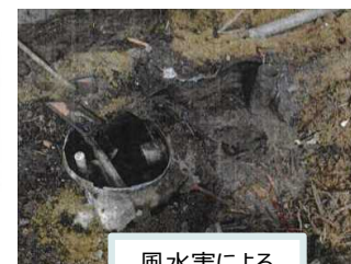
風水害による 破損のリスク
