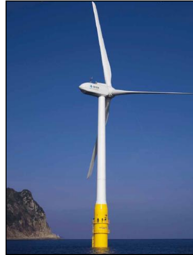
国内初2MW浮体式洋上風力発電機
