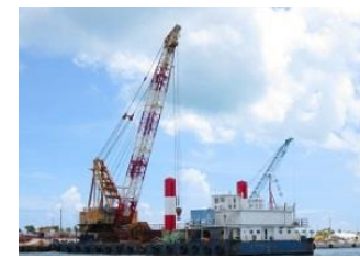
施工クレーン台船
