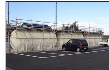
【応急仮設住宅に設置された浄化槽】
