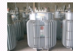
PCBが含まれる 高圧トランス
