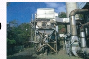
老朽化した廃棄物処理施設の更新
