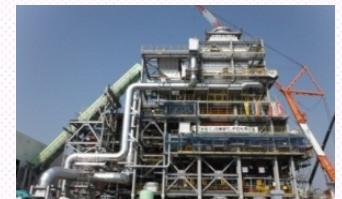
仮設焼却炉の建設状況(対策地域内廃棄物)
