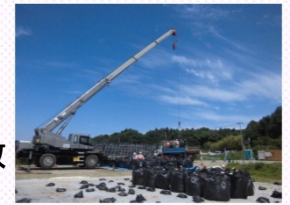
除去土壌等の搬出の様子
