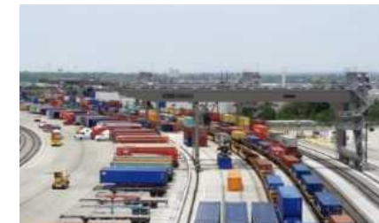
門型クレーン
