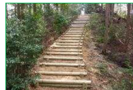
【東海自然歩道】登山道整備
