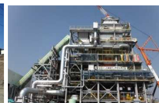
浪江町の仮設焼却施設 (平成27年4月)
