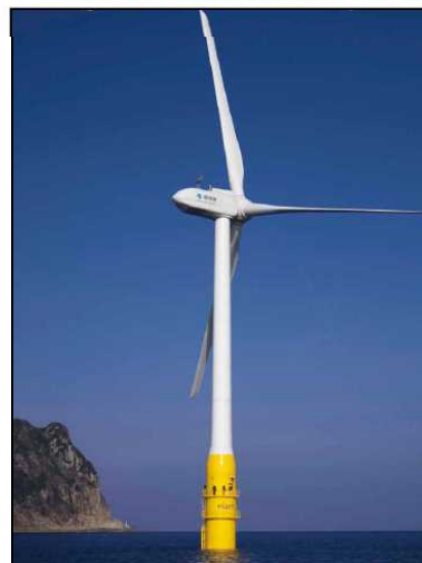
国内初2MW浮体式洋上風力発電機
