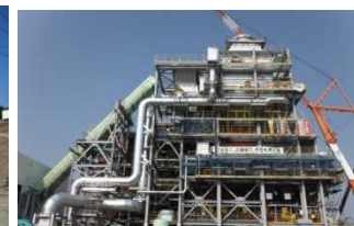
浪江町の仮設焼却施設 (平成27年4月)
