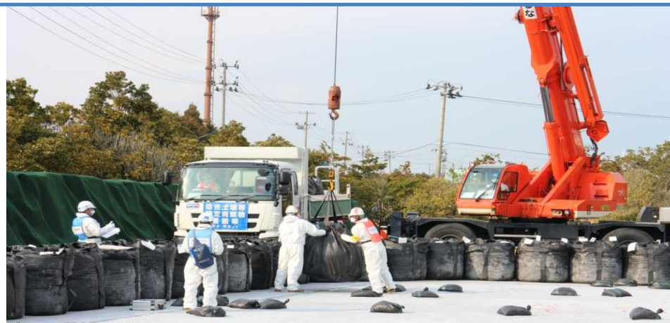
保管場への搬入・定置作業 (大熊町内)
