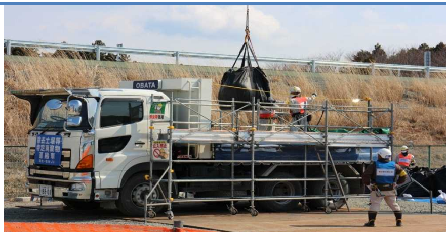
大熊町南平仮置場からの搬出作業
