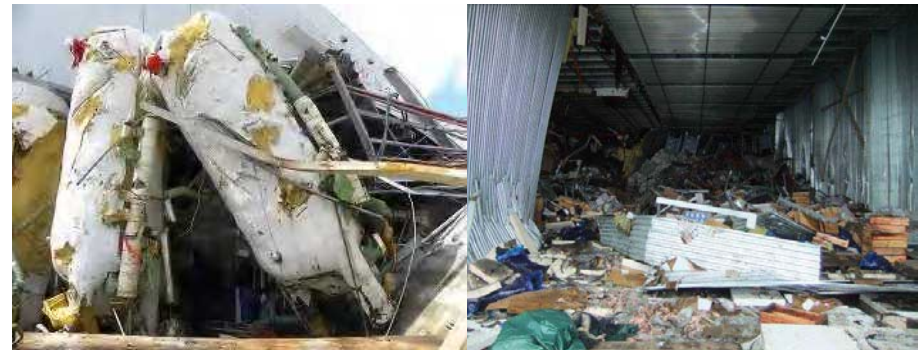
宮城県内食品工場冷凍機
