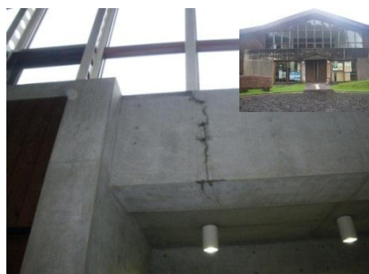
コンクリート梁の損傷 (屋久島世界遺産センター)
