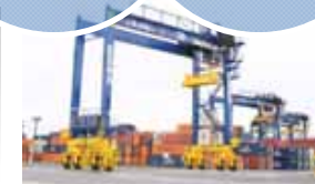
トランスファークレーン
