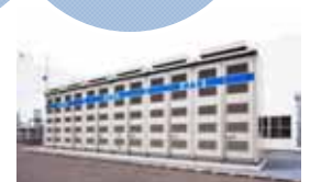
大容量蓄電池
