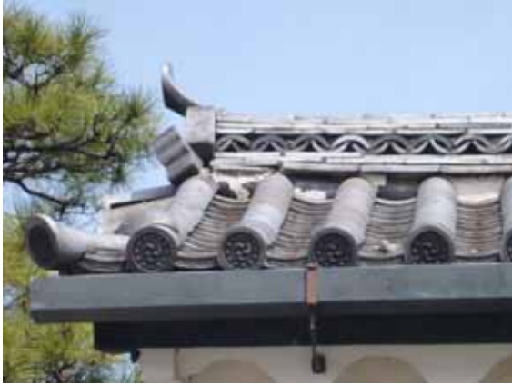
桜田門瓦崩落
