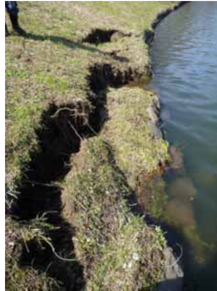
桜田濠石垣崩落
