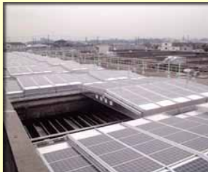
爆発的な普及が進む太陽光電池
