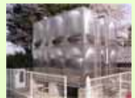
余剰冷温水や熱等の大容量貯蔵の設備導入
