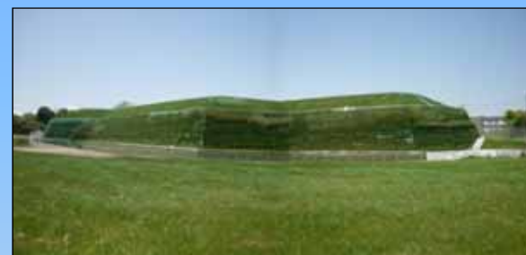
不法投棄等の支障除去等事業の跡地
