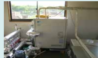
小水量搬送地中熱ヒートポンプの導入
