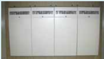
家庭用リチウム蓄電池の導入
