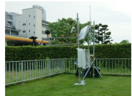
(2) WBGT計の設置状況
