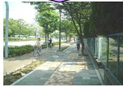
歩道、自転車道の整備
