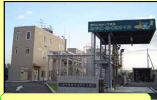
給油施設 (京都市南部クリーンセンター)
