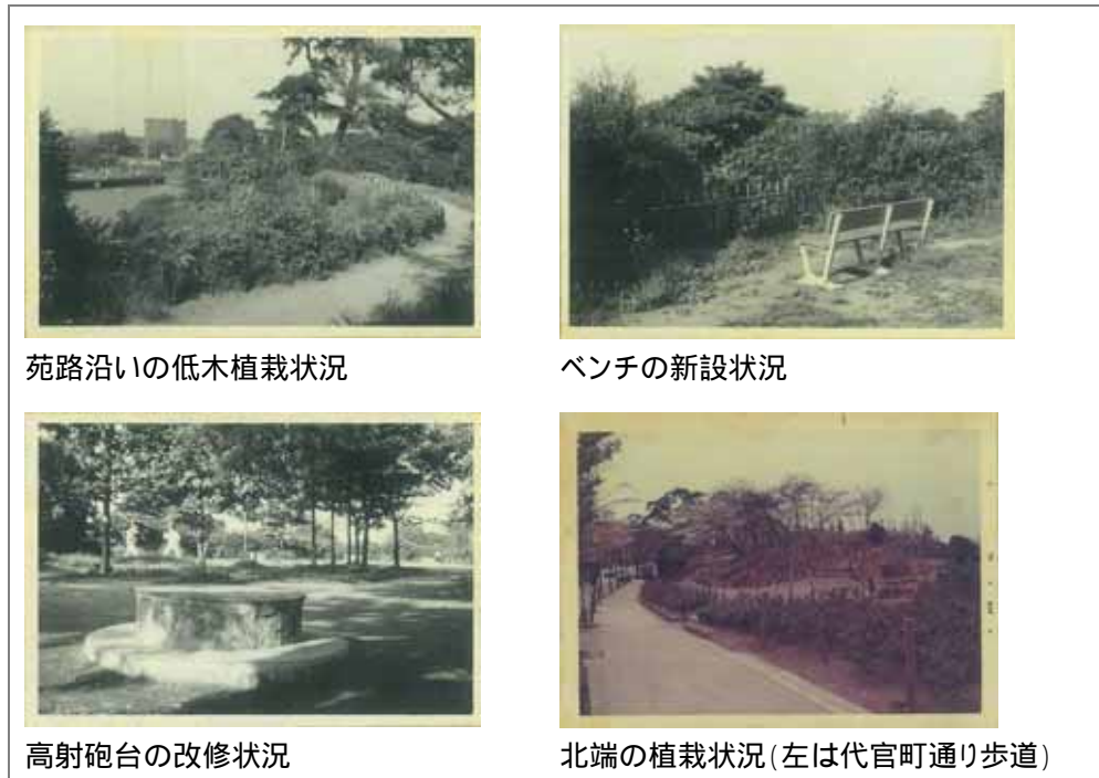
昭和 44 年度の代官町通り修景工事 竣工直後の様子
