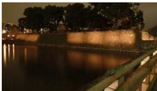
夜間照明施設の整備
