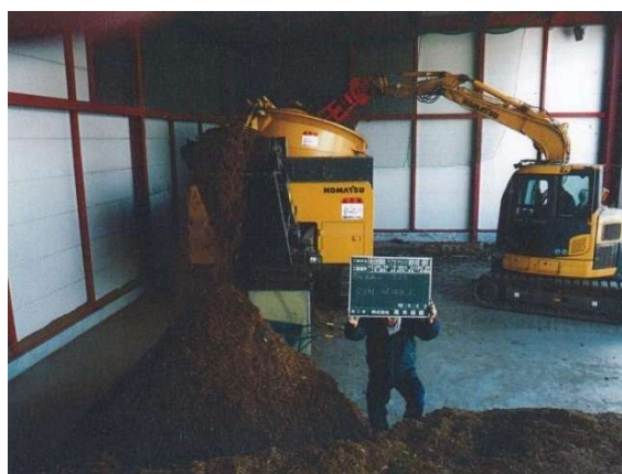
搬出した被害木のチップ化作業
