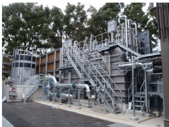
図 2.1 新浄化施設の状況
