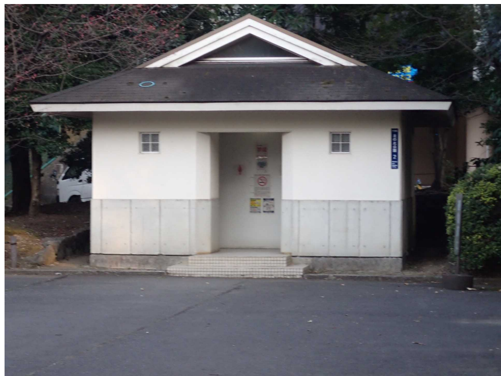
②⑩清水門広場トイレ
