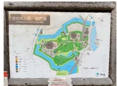
案内板 (表示面の劣化)
