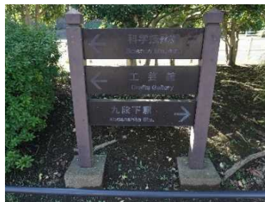
誘導案内板 (表示面の劣化)
