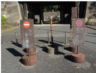
制札版 (表示面の劣化と鉄部の錆)
