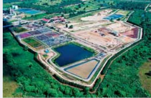
Source : DOWA Eco-System Co., Ltd.
