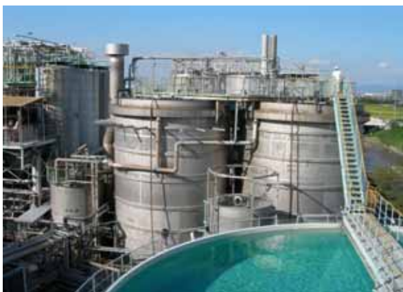
Ảnh: thiết bị xử lý yếm khí UASB ở nhà máy đường fructoza
