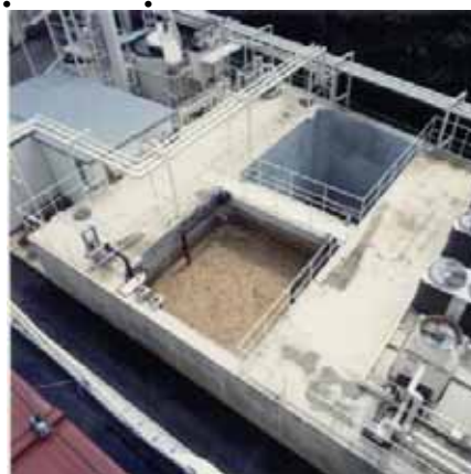
Ảnh: thiết bị xử lý sục khí hạn chế ở nhà máy bánh kẹo
