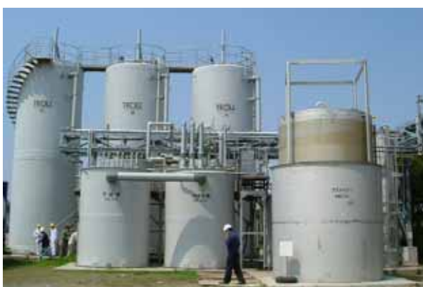
Ảnh: thiết bị xử lý yếm khí UASB ở nhà máy xi dầu
