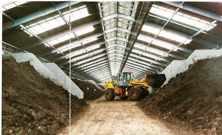
รูป E.1 อาคารที่ทำการหมัก
