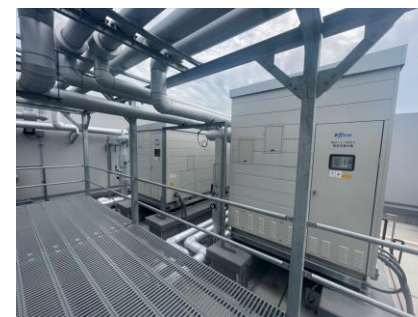
ガス焚吸収式冷温水機 (280kW×2台 うち1台廃熱投入型)
