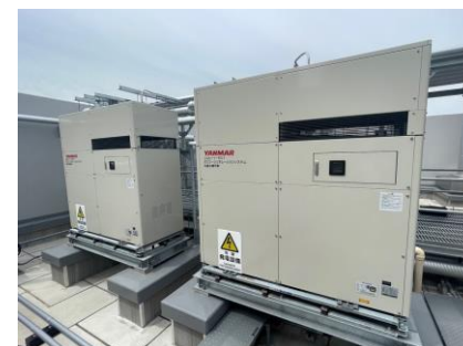
マイクロガスコージェネレーション (35kW型×2台)
