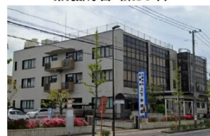
上下水道部合川庁舎（築36・52年）
