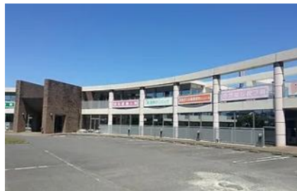
津市観音寺町TTC医療グループビル底地
