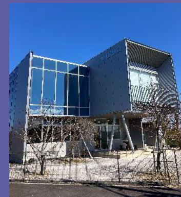
津営業所 津営業所も空調機改修 の時期であった
