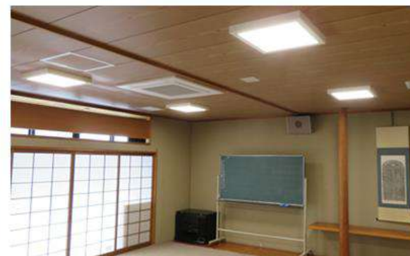
エアコン室内機とLED照明
