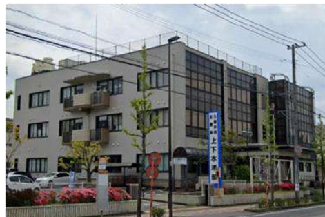
上下水道部合川庁舎（築36・52年）
