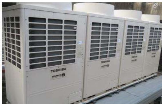
マルチエアコン室外機
