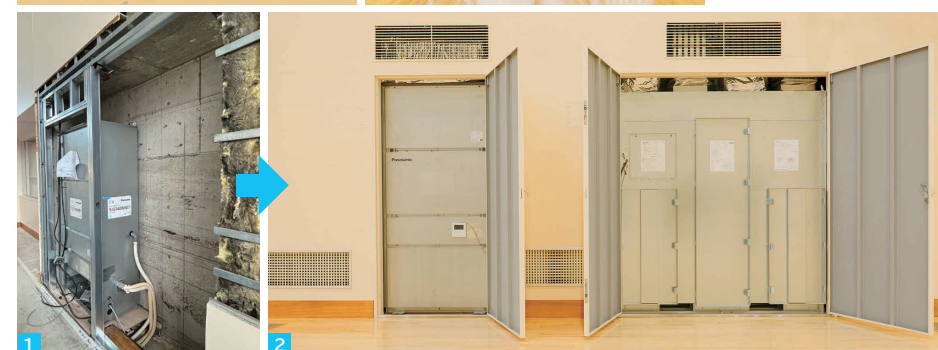
1.既設の暖房設備のあった場所に新しく空調を配置 2.改修後は床面に近い場所から冷気を吹き出し、高さ2mのところから空気を吸い込むようにし、空気の循環を図っている
