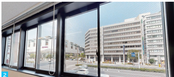
1. 外壁にはウレタンフォームを吹き付け、窓にはLow-E複層ガラスを採用 2. Low-E複層ガラスは遮音性も高く、外部の騒音もシャットアウト
