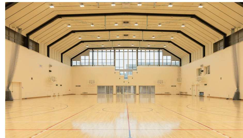
1.既設の暖房設備のあった場所に新しく空調を配置 2.改修後は床面に近い場所から冷気を吹き出し、高さ2mのところから空気を吸い込むようにし、空気の循環を図っている
