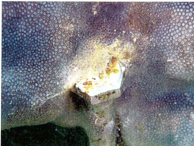
図6-21. アンカーボルトを包み込んで生長するサンゴ
