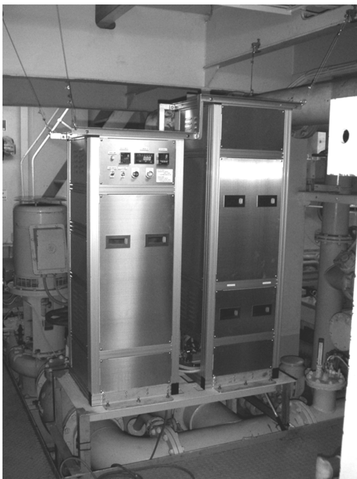
図1 客船の機関室に搭載した海洋観測システム 写真の左側ラックは濃縮捕集部、右側ラックは海洋基礎項目観測用センサーおよびロギング用パソコン格納部
