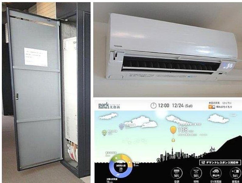
図 2-31 YSCP の自動 DR 対応エアコンとヒートポンプ給湯機 出所「住民の快適性を損なわない自動節電策を実証へ」（Japan Smart City Portal）
