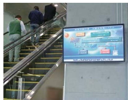
エレベーター横に設置された来庁者向けモニター
