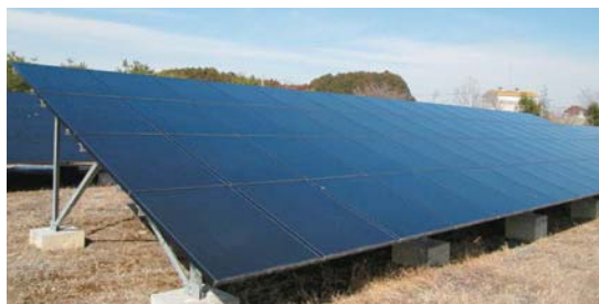
敷地内に設置された太陽光パネル
