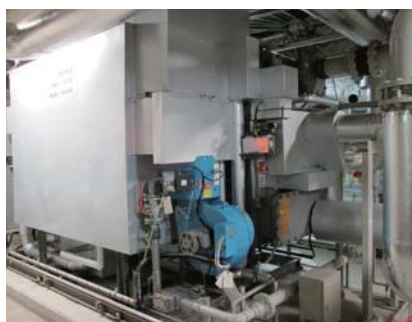
高効率ガス吸収冷温水機
