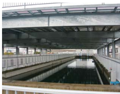
沈澱池を横から見る
