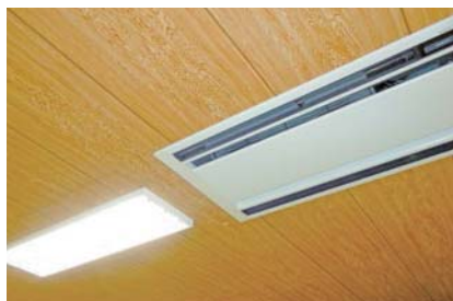
空調は全館、LEDは適所に設置
