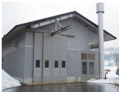
木質ペレットボイラー用の建屋
