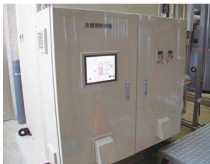
タッチパネルで操作する床暖房設備
