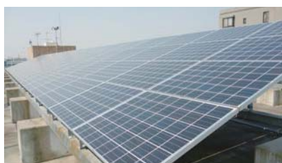
屋上に設置された太陽光パネル
