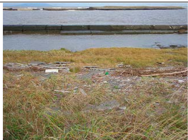
天塩川河口付近左岸の状況：河岸に流木や人工物が打ち上げられている。
