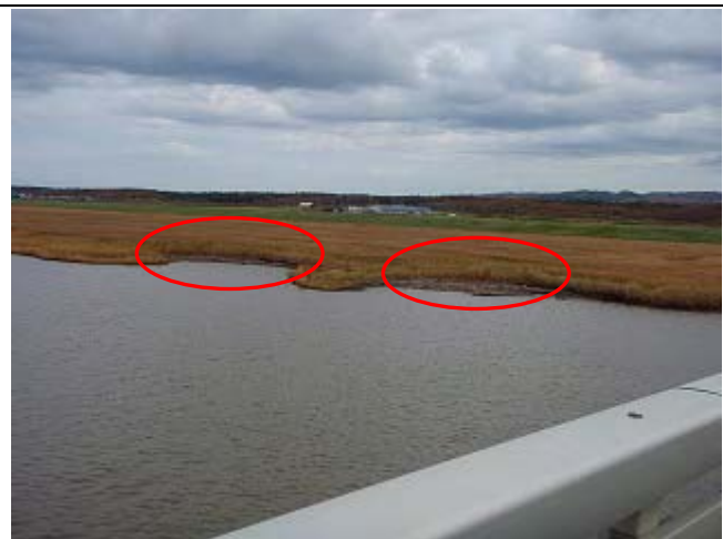
天塩河口大橋から上流左岸の状況：河岸凹部に流木が浮いている（赤丸内）
