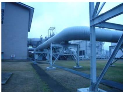
写真 7-27 蒸気輸送管（滝上地熱発電所）
