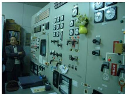
写真 7-26 九重観光ホテルの発電制御盤
