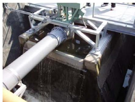
写真 7-9 伊勢崎浄化センターの水力発電機
