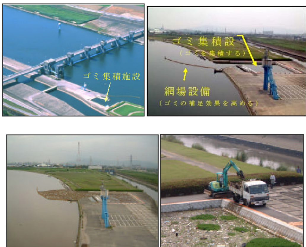
図 7.1-1 筑後大堰のゴミ集積施設（上）とゴミ回収状況（下） 2
