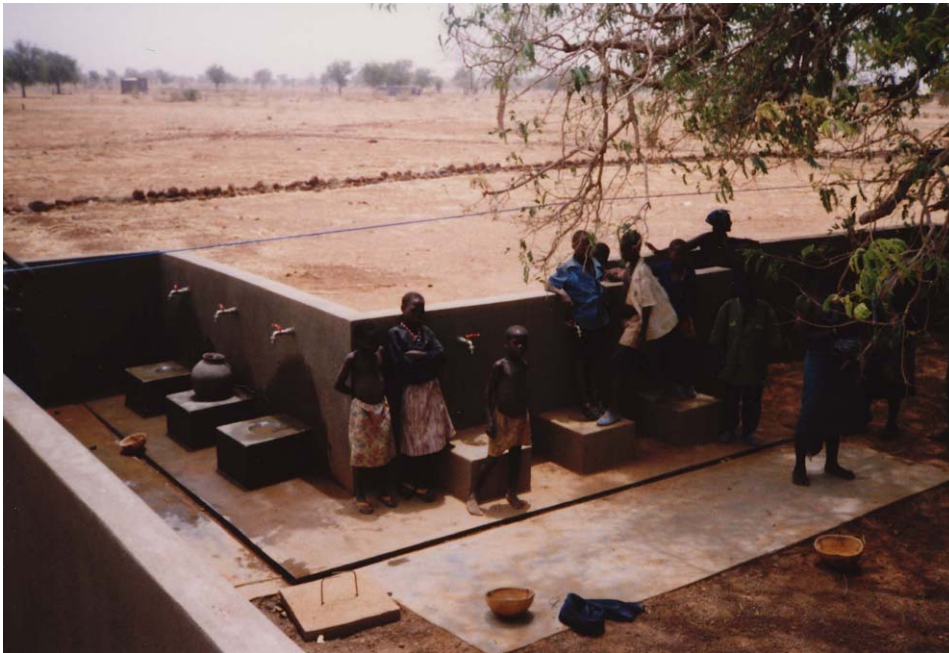
写真 7.3 コンバンベド村 (Kombangbedo) に作られた生活用給水施設
