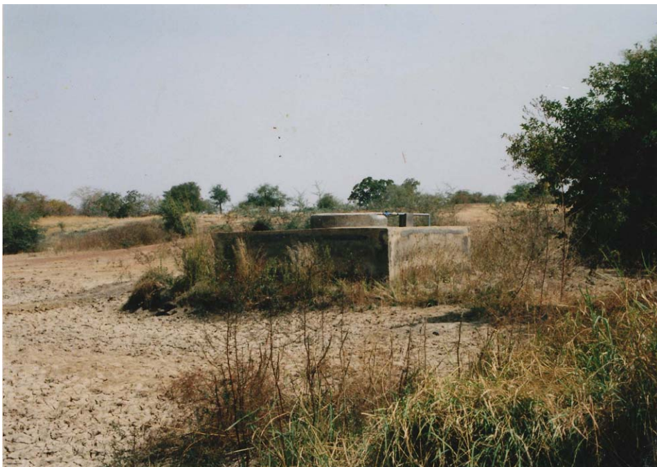
写真 7.2 地下ダム貯水域に設置された揚水井
