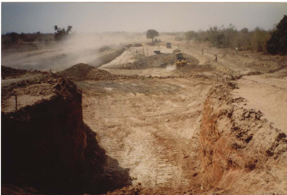
写真 4.2 : 地下ダム建設工事 (2)
