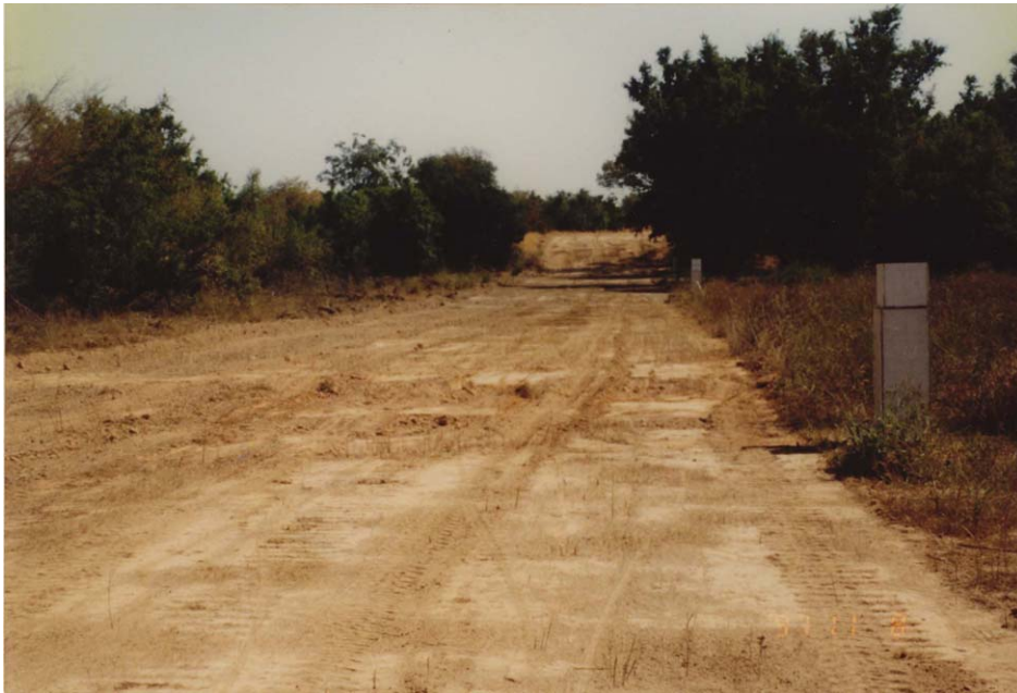
写真 4.1 : 地下ダム建設工事 (1)
