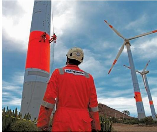
図 4-115 ロープアクセス技術を用いた風車の保守点検
