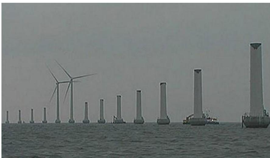
図 4-139 Middelgrunden Offshore Wind Farm の建設段階の様子
