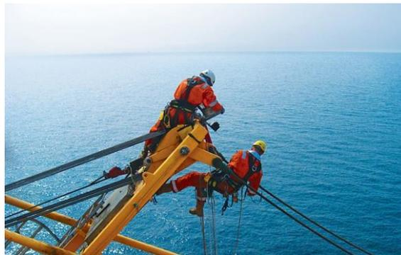
図 4-116 洋上油田・ガス田におけるロープアクセス技術を用いた保守点検
