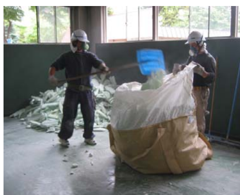
図 分離断熱材の回収作業
