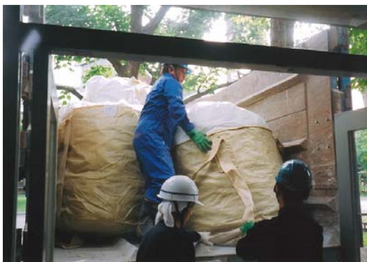
図 回収断熱材の積み込み作業
